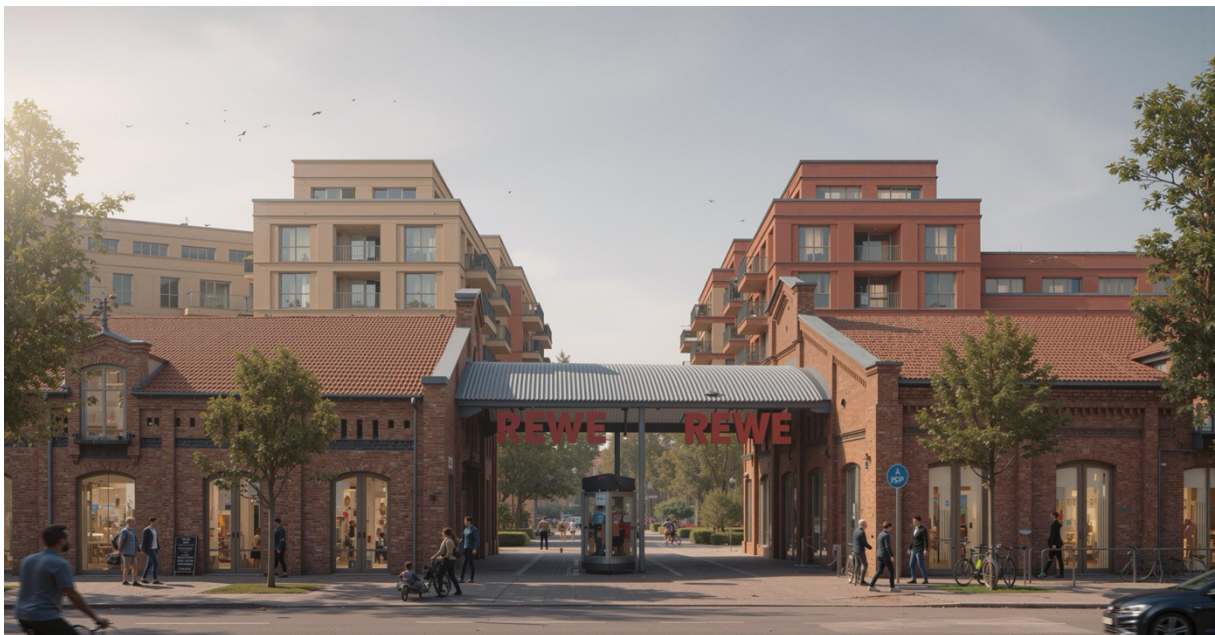
Blick von Norden auf die ehemaligen Hammelställe und die beiden Neubauten. © Klaus Theo Brenner – Stadtarchitektur
